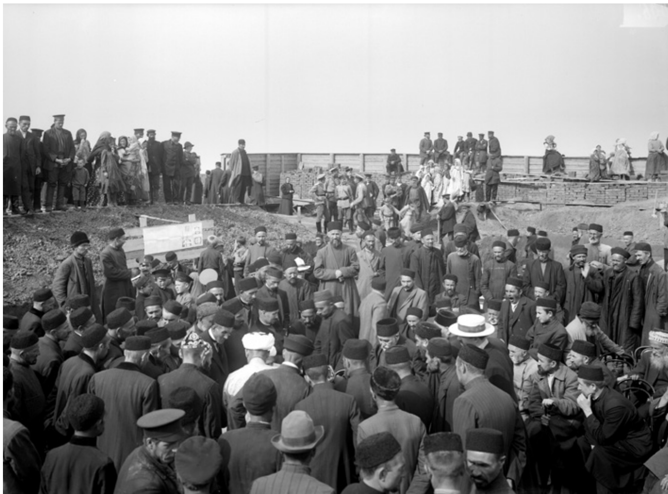
Сенная площадь. Церемония закладки Нижегородской соборной мечети. Автор съемки: М. П. Дмитриев. 1913 г. ГКУ ГАрхАДНО. Оп. 6. Ед. хр. 1006.
